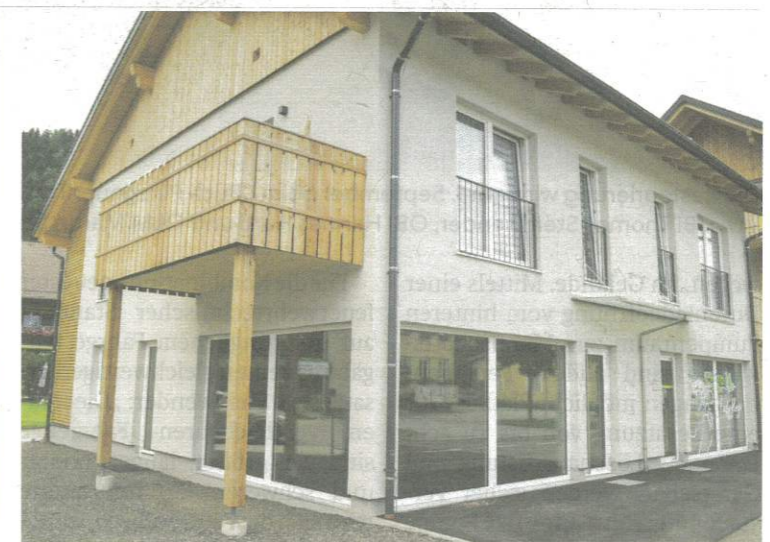
In der ersten Baustufe wurden zehn Wohnungen und fünf gewerbliche Flächen geschaffen.
