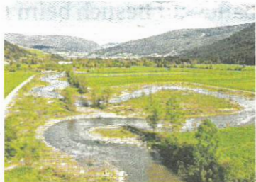
Dieser Mäander in St. Michael ist Teil des Gesamtprojektes. Land Salzburg
