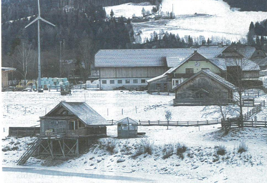
Das Kleinwindrad befindet sich im St. Michaeler Ortsteil Oberweißburg, wenige Kilometer von der Autobahnabfahrt entfernt.
