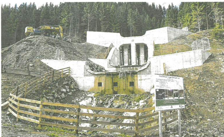
2020 wurde mit der Verbauung des Taferngrabens begonnen.
