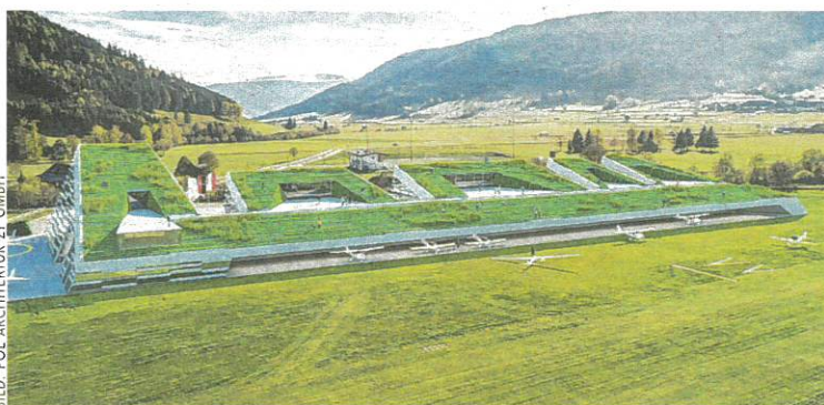
Schon der Erstentwurf zeigt, wie ideal sich das neue Projekt in die Lungauer Berglandschaft integrieren ließe.
