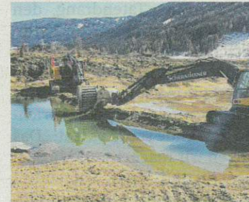
Diese zwei Bagger ließen das Murwasser ein.
