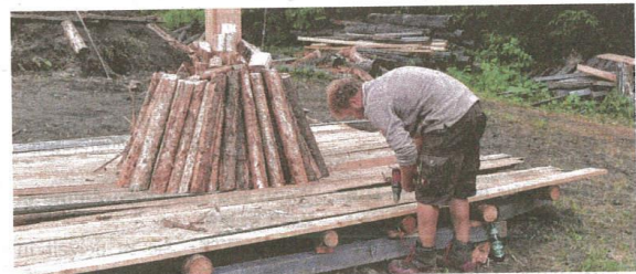
Andreas Zehner befestigt hier gerade den Holzboden für den zweiten Rundholzmeiler. Foto: Andreas Zehner - Landjugend Unternberg
