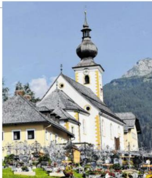
Teile des Schindeldaches der Pfarrkirche in Zederhaus sind mehr als 50 Jahre alt. Witterungsbedingt bekommen die Schindeln mit der Zeit eine silbergraue Färbung.
