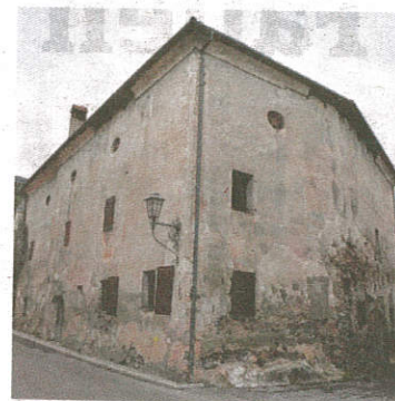
Der Neuwirtstadel soll das neue Biosphärenpark-Zentrum werden.
